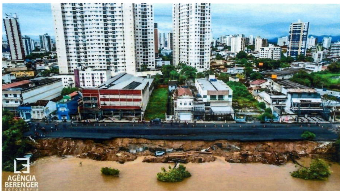
Figura 2 - Vista Geral do Colapso
