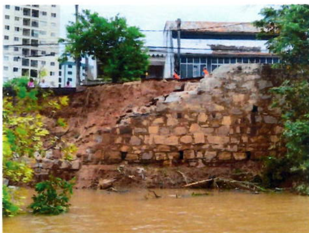
Figuras 3 e 4 – Muro de Contenção da Via em Pedra Argamassanda
