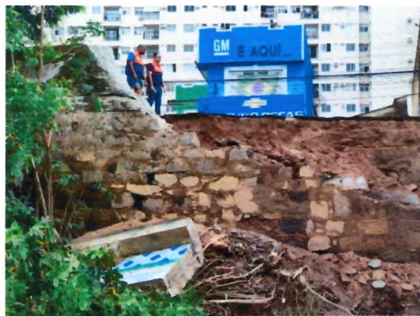
Figuras 3 e 4 – Muro de Contenção da Via em Pedra Argamassanda
